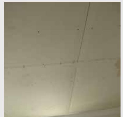
عدم رعایت حصرچینی در پنل‌ها
