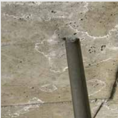
عدم استفاده از اتصال مناسب به سقف اصلی
