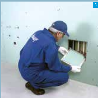
نصب قاب درب دریچه
