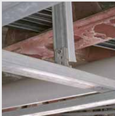
عدم اجرای جزئیات آویزگیری
