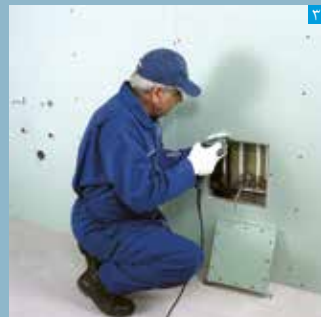
قرار دادن قاب اصلی دریچه درون دیوار و بیج کردن آن به پنل
