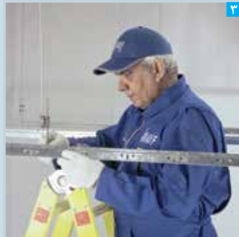
۳ اجرای سازه های اصلی T3600
