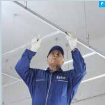
۴ اجرای سازه های فرعی T1200
