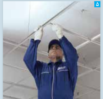
۵ اجرای سازه های فرعی T600
