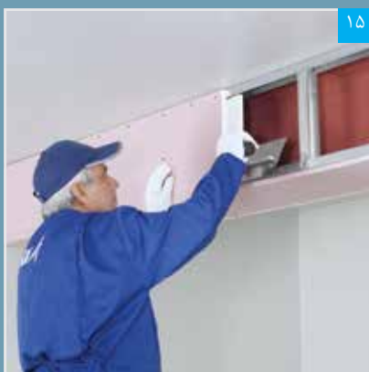
۱۵ اجرای فوگن فولر بر روی نیمه دیگر پنل پشت بند درز (پس از خشک شدن فوگن فولر نیمه اول)
