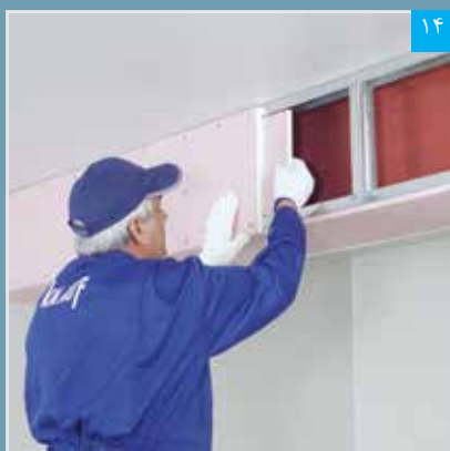
۱۴ اتصال پنل پشت بند درز به پنل جانبی
