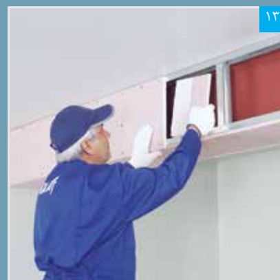
۱۳ استقرار پنل پشت بند درز
