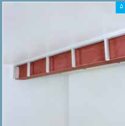
۵ سازه های فوقانی و قائم تکمیل شده
