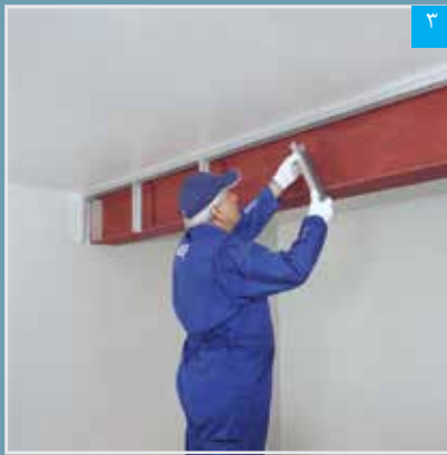
۳ اجرای سازه های قائم
