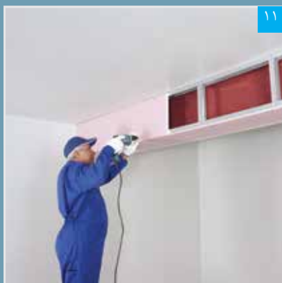
۱۱ اجرای پنل جانبی
