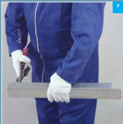
۶ برش سازه پشت بند درز (به صورت زیانه)
