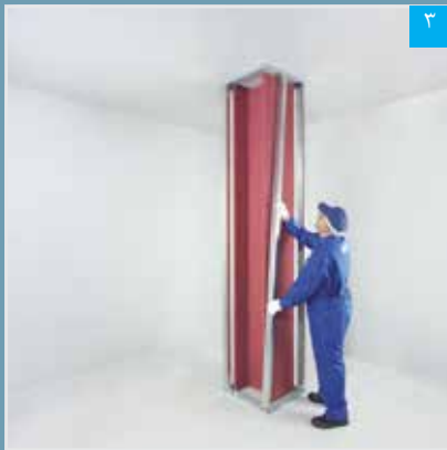
۳ استقرار استاداها در رانرهای کف و سقف
