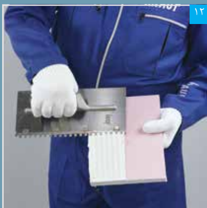
۱۲ اجرای فوگن فولر بر روی نیمی از پنل پشت بند درز (با استفاده از ماله دندانه دار)
