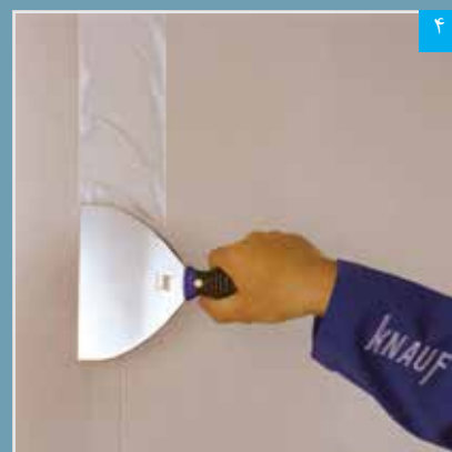
مرحله اول درزگیری: اجرای لایه بتونه در محل درز (کاردک در جهت عمود بر درز کشیده می‌شود تا بتونه کاملاً در درز نفوذ کند)
