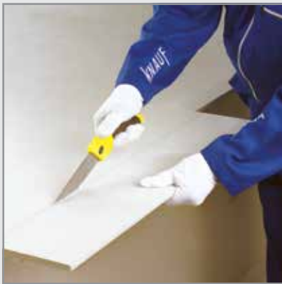
برش پنل با ااره دستی
