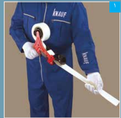
۱ خم کردن نوار درزگیر با دستگاه تازن
