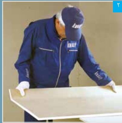
شکستن پنل در محل برش
