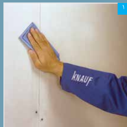
تمیز کردن سطح، قبل از بتونه کاری و یا اجرای ماستیک بسیار مهم است
