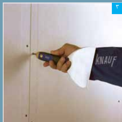
فرو بردن سر پیچ‌ها با پیچ گوشتی پشت کاردک
