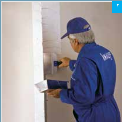
اجرای بتونه روی سازه محافظ گوشه
