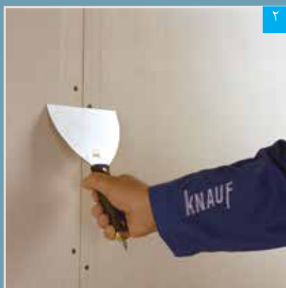
بررسی بیرون زدگی پیچ‌ها با کاردک
