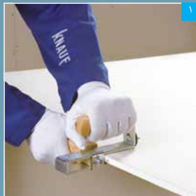
برش پنل با دستگاه برش قرقراهی
