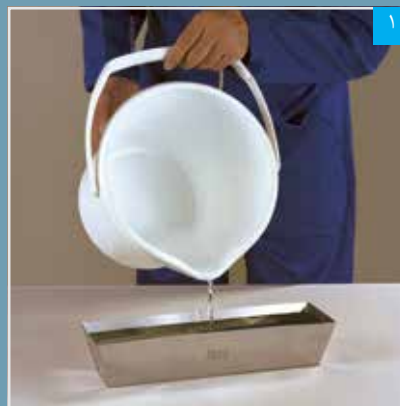
ریختن آب در ظرف تهیه بتونه
