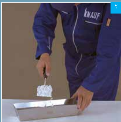
ریختن پودر بتونه در آب
