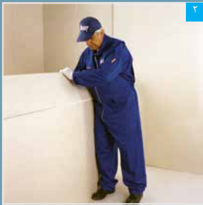
شکستن پنل در محل برش
