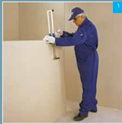
برش پنل با دستگاه برش طولی
