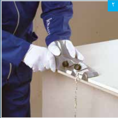
اجرای پخ با پخ زن
