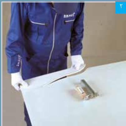
جداکردن پنل از محل برش
