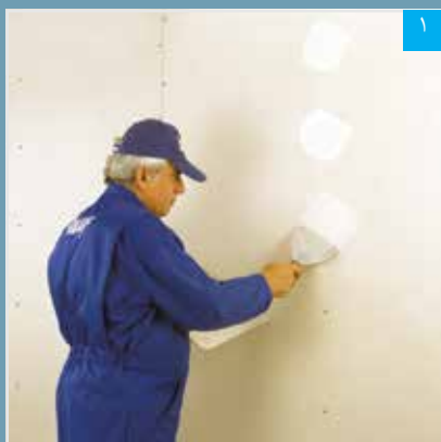
اجرای بتونه در محل پیچ‌ها
