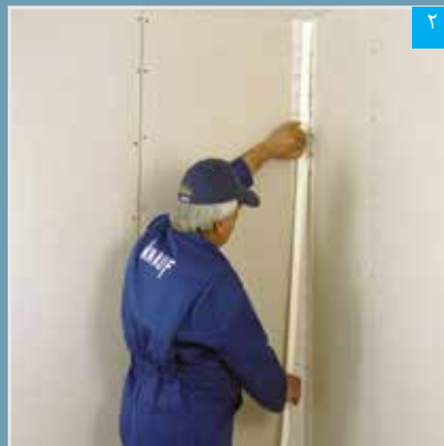
۲ قرار دادن نوار درزگیر بر روی بتونه
