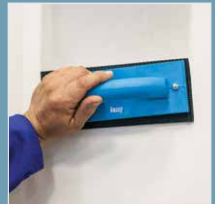
مرطوب کردن سطح دیوار با اسفنج نمدار
