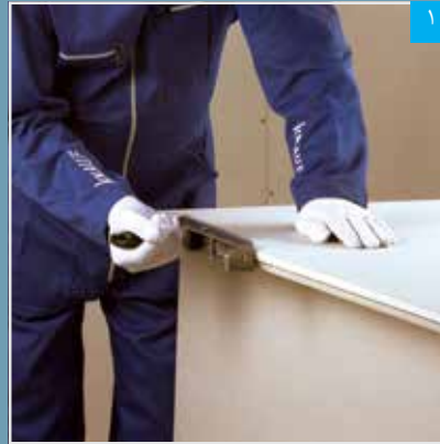
پرداخت لبه برش خورده با رنده
