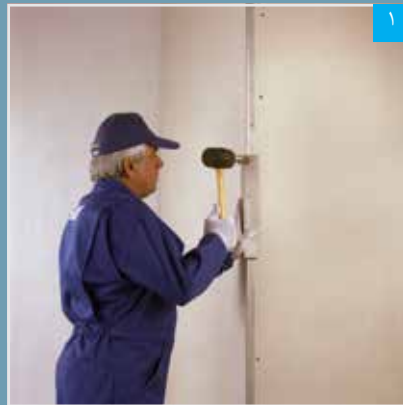
نصب سازه محافظ گوشه با دستگاه کرنربرد کوب
