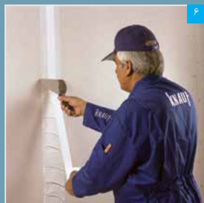
قرار دادن نوار درزگیر بر روی بتونه
