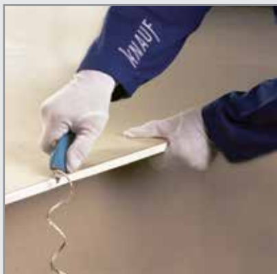
اجرای پخ با تیغ برش
