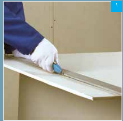
ایجاد شیار (برش کاغذ روکش) بر روی پنل
