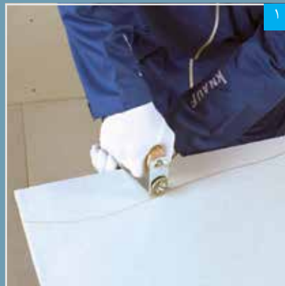
اجرای برش موج‌دار با دستگاه برش قرقراهی
