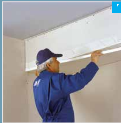
۲ قرار دادن نوار درزگیر بر روی بتونه
