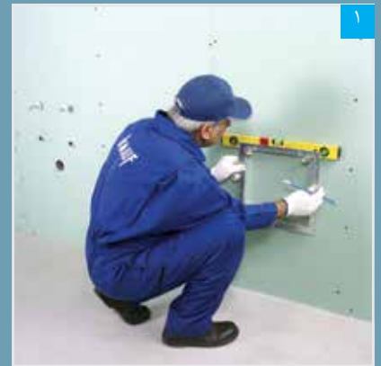
علامت گذاری محل دریچه (با استفاده از قاب دریچه)
