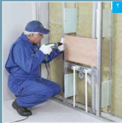
۲ اتصال تراورس (تخته چند لایه) به قطعات نبشی L25
