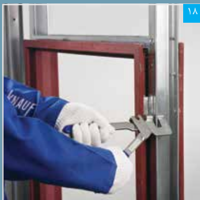
۱۸ اتصال رانر نعل درگاه به استادها با پانچ
