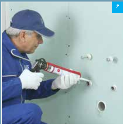
۶ اجرای خمیر درزبند در اطراف خروجی‌های تاسیساتی
