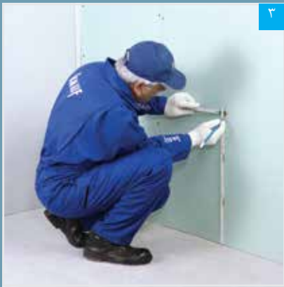
۳ تعیین محل خروجی‌های تاسیساتی
