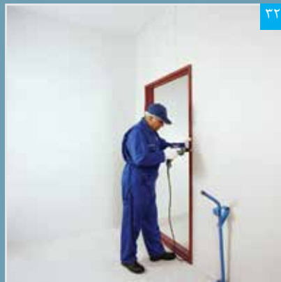
پیچ زنی پنل در حاشیه دور چهارچوب و تکمیل پوشش کاری
