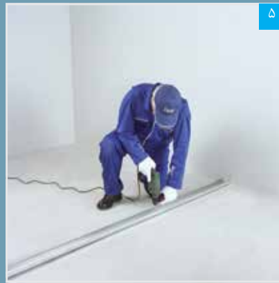
۵ نصب رانر کف (سوراخ کردن رانر و کف)
