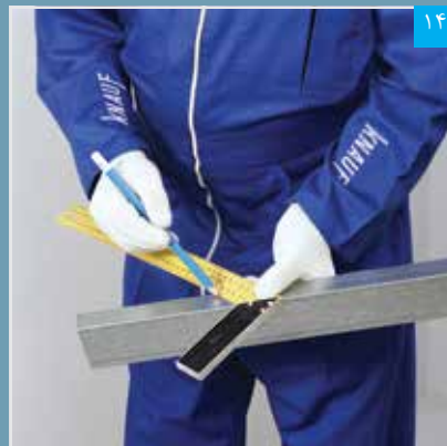
۱۴ علامت گذاری انتهای رانر نعل درگاه به صورت فارسی بر (به اندازه ۲۰ سانتیمتر)
