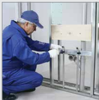
اتصال لوله‌های تاسیساتی به سازه پشتیبان SP60
