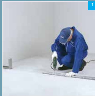
نصب رانر کف
