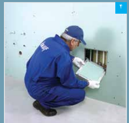
قرار دادن پنل دریچه در درون قاب
