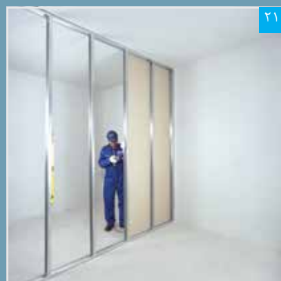
اجرای پنل‌ها در یک طرف دیوار
