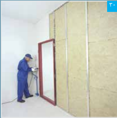
پیچ زنی پنل در حاشیه دور چهارچوب
