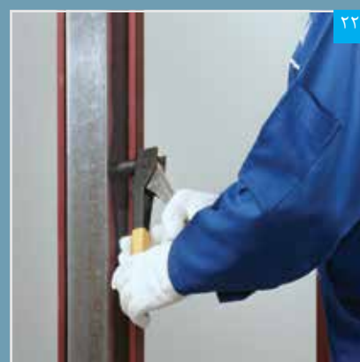
رانر تقویتی توسط پرچ به استاد متصل می‌شود
