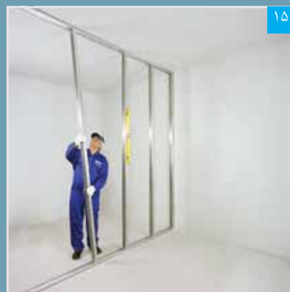
اجرای استادهای (به صورت شاقولی)
