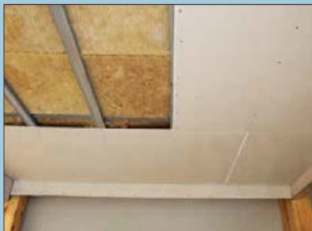
عایق کاری صوتی سقف ساختمان با سقف کاذب کتاف
