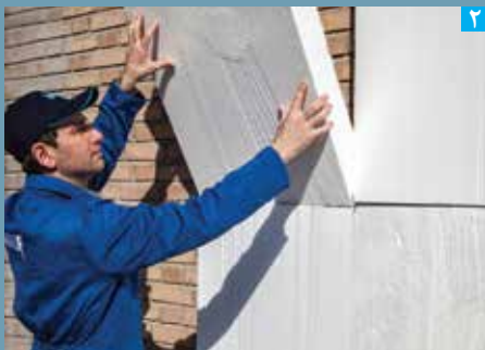
نصب قطعات عایق بر روی دیوار زمینه
