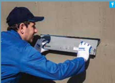
اجرای اندود SM700
