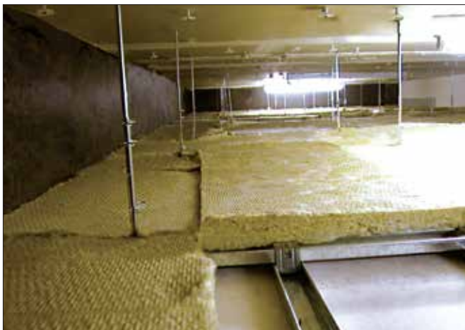
عایق کاری پیلوت
