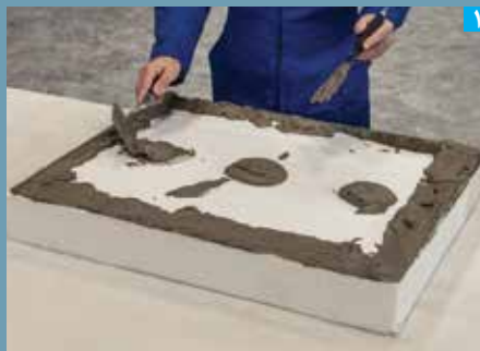
نشاندن چانه‌های SM700 بر روی قطعات عایق
