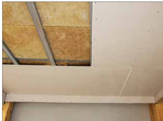
عایق کاری سقف ساختمان
