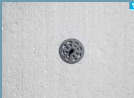
نصب بستهای Termofix
